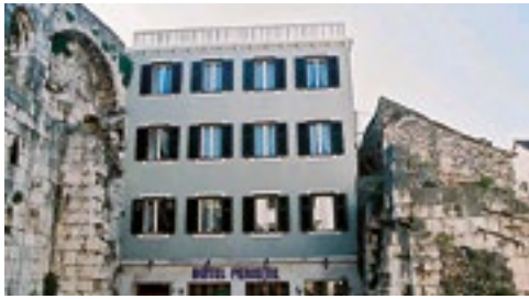
Hotel Peristil Split (Croazia)
